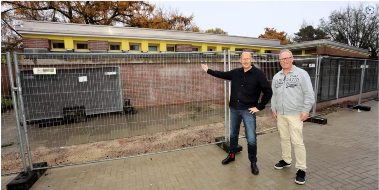
Schulleiter Tobias Langer (links) und sein Kollege Chris Caspers an der Stelle, wo der Abriss demnächst richtig losgeht. Foto: Christian Bittcher
